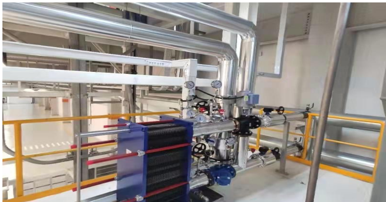
图5-余热应用于涂装水洗系统
